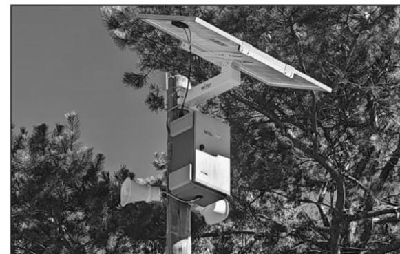
El sistema, innovador y alimentado por energía solar, cuenta con un router 4G que garantiza conexión constante. Permitirá reportar información en tiempo real, enviar alertas inmediatas y transmitir audios en vivo ante cualquier situación de emergencia. Se trata del primer equipo de este tipo instalado en el departamento, dentro de las 192 hectáreas de relevancia ambiental y patrimonial del Arboretum.
